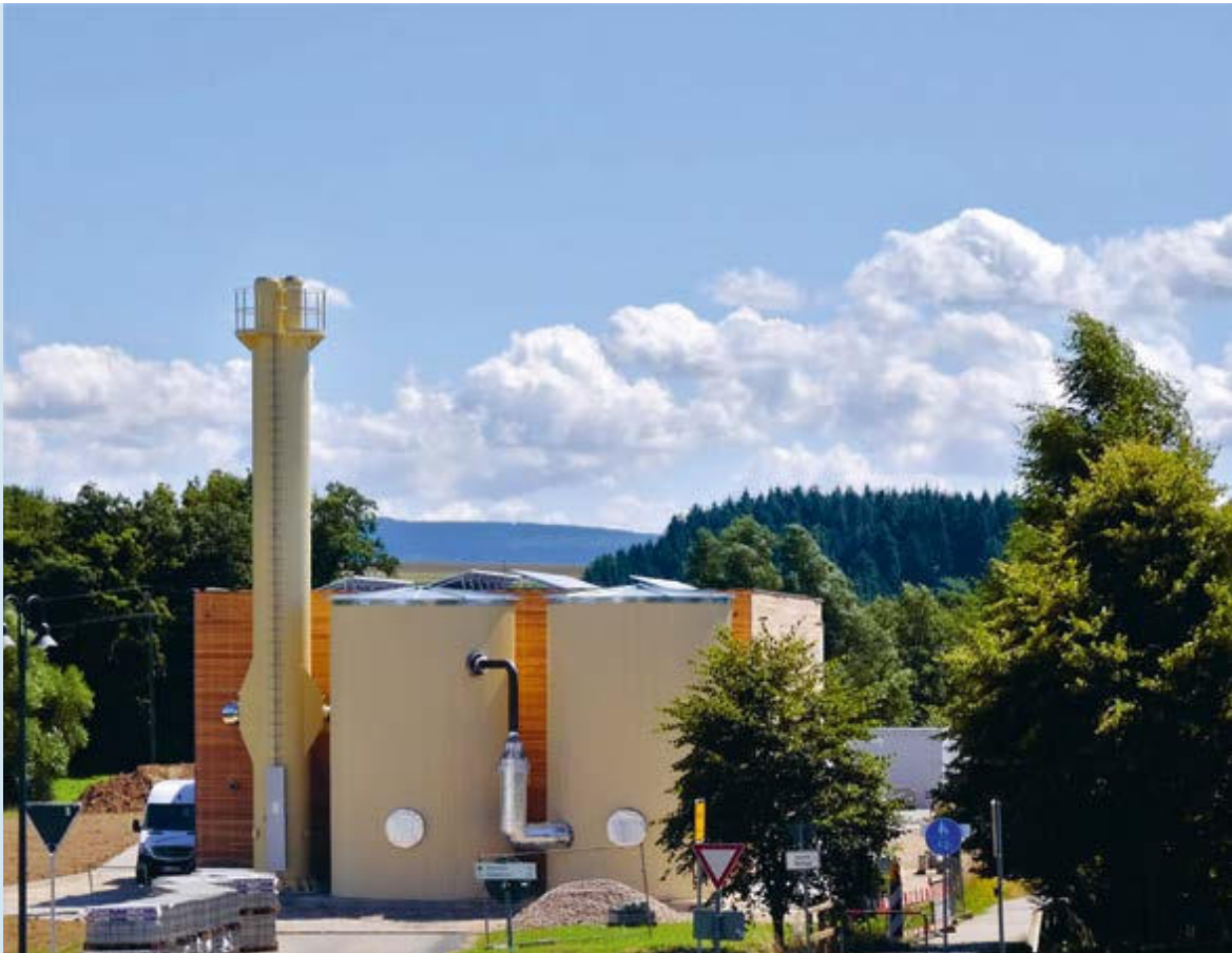
Außenansicht des Heizwerks Neuerkirch-Külz
